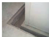
Dettaglio Scavo Excavation example
